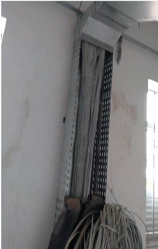
Cabos UTP em espera para rack
