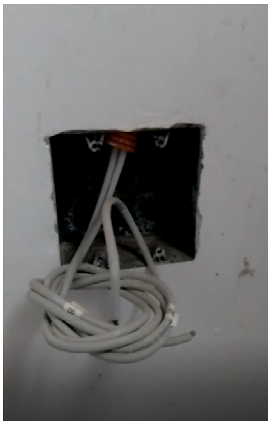
Cabos UTP em espera para tomada
