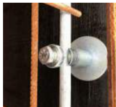
Aplicação do ATERRINSERT® EASY Tel 650 com Rebar em pilar estrutural
