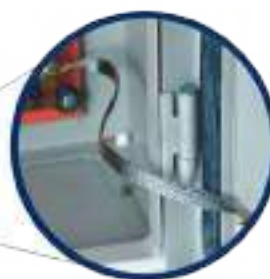
Detalhe do aterramento da tampa
