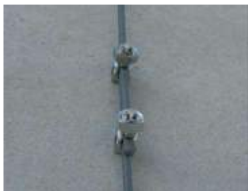
Utilização da Rebar como condutor externo.
