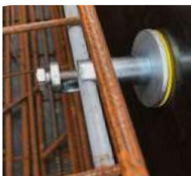
Aplicação do ATERRINSERT® EASY Tel 650 em viga
