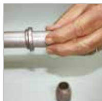
Introduzir a Junta de Vedação no Eletroduto.
