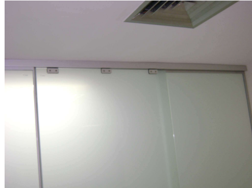
Detalhe da dobradiça superior
