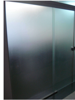
Detalhe da porta
