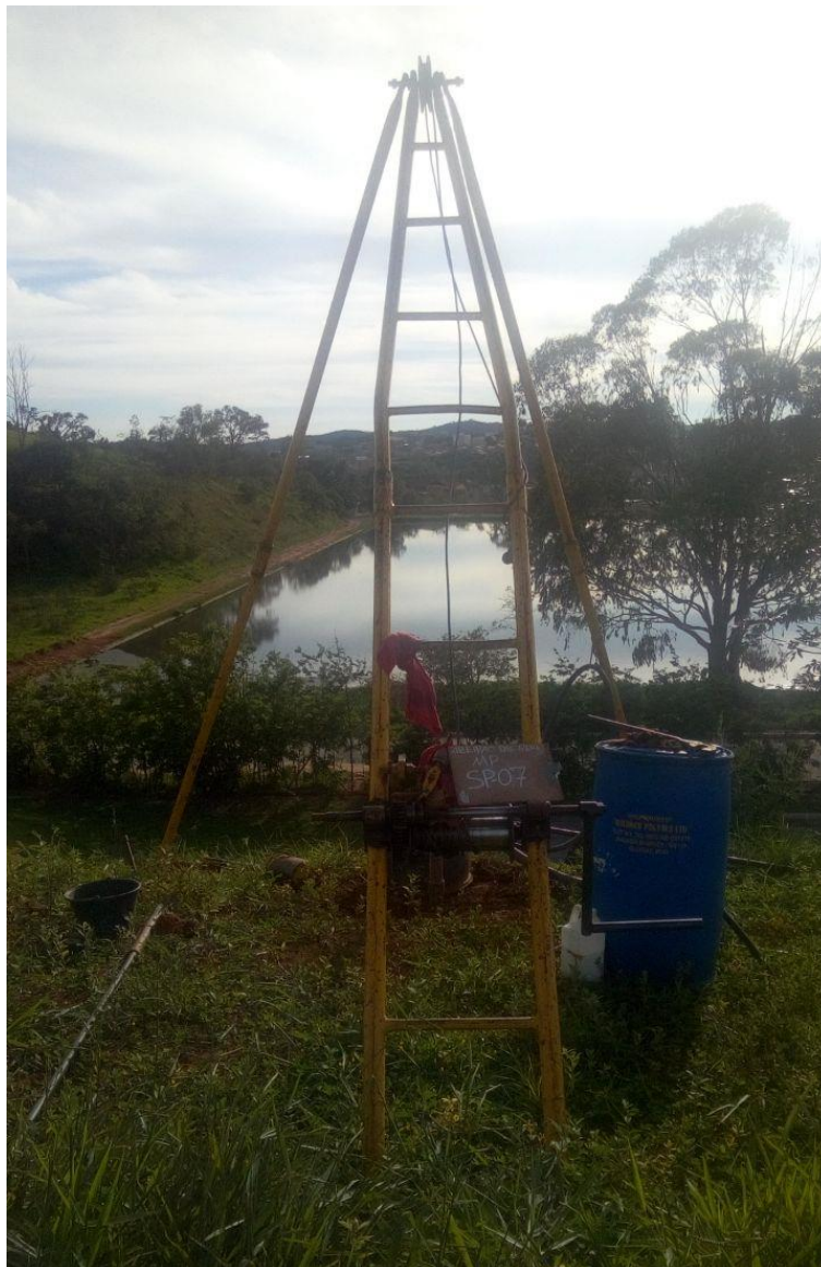
Instalação do furo SP07
