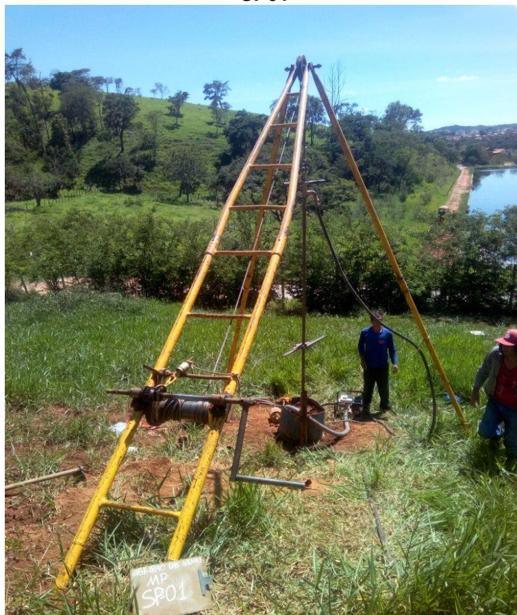
Instalação do furo SP01
